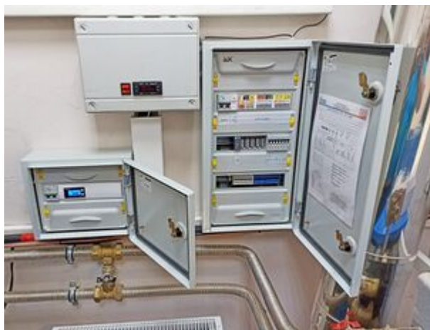
Установка контроллера ZONT H2000+ для
